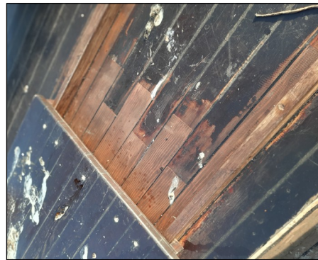
Rénovation du roof du carré
