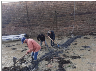
Enterrement du câble
